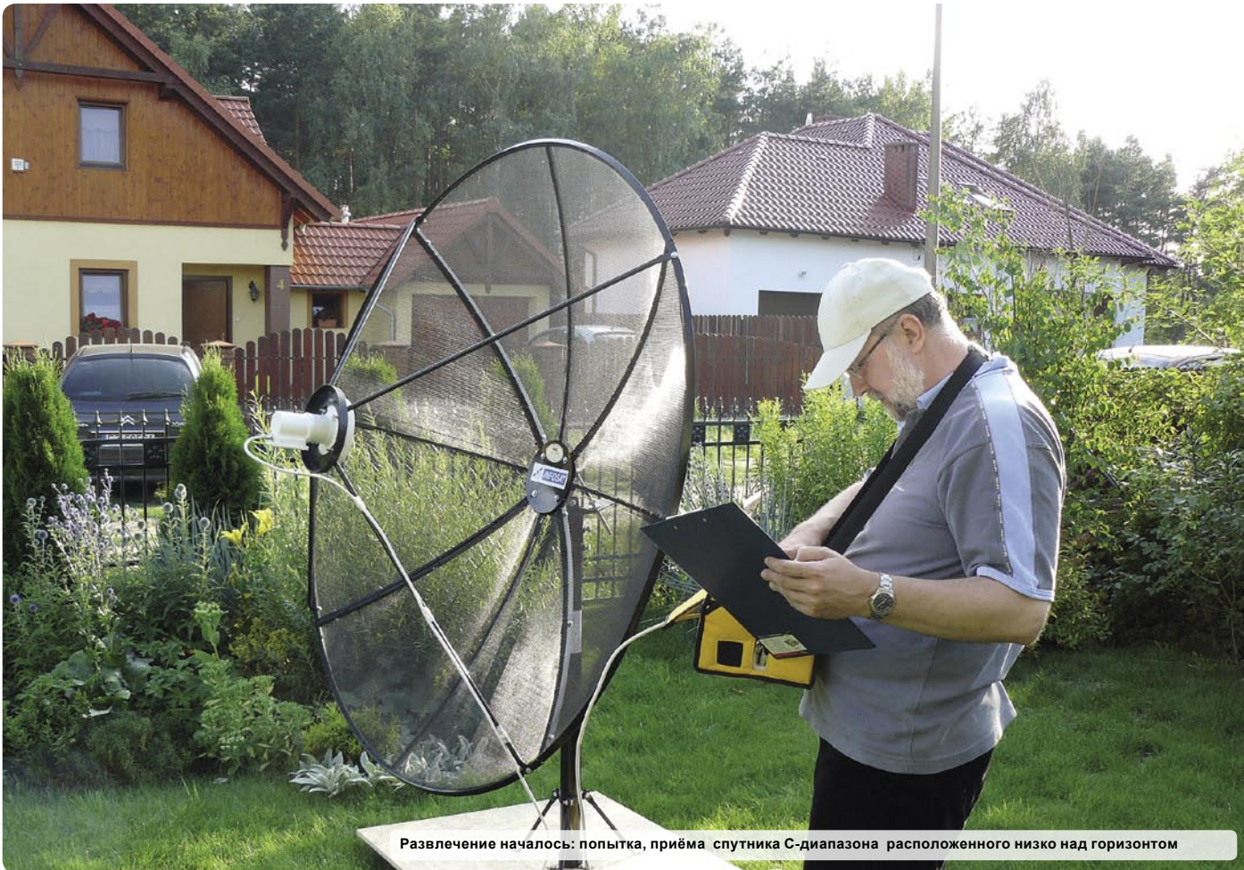
Пришло время прицелить антенну. Мы рекомендуем использовать водный уровень, оснащенный транспортиром, который делает установку возвышения значительно проще.
